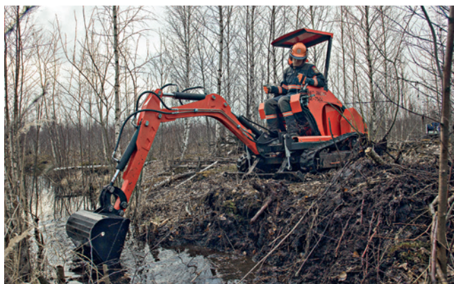
Рис. 84. Неполноповоротный миниэкскаватор шириной 1,45 м на работах по перекрытию канала
