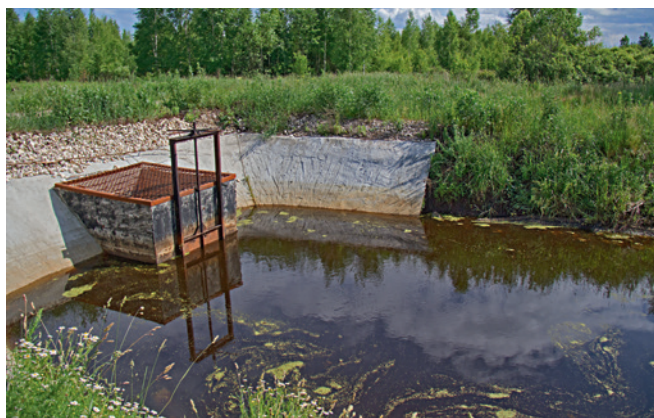
Рис. 7. Действующее гидротехническое сооружение с подъёмной задвижкой
