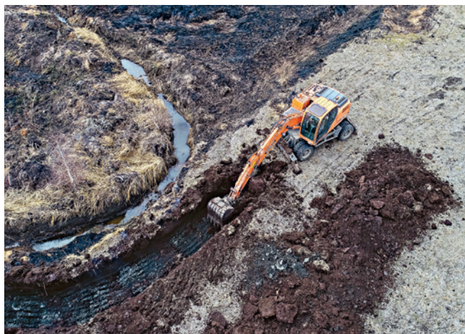
Рис. 60. Правильная локализация очага канавой до минерального грунта (отвал наружу). Между отвалом и канавой оставлен проход
