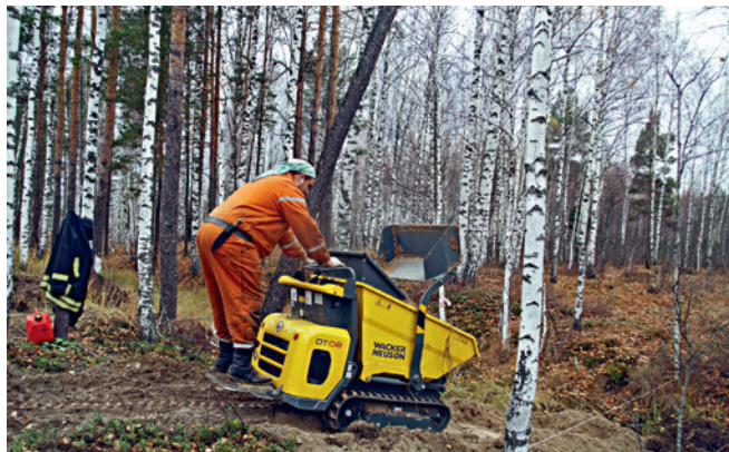
Рис. 83. Обустройство песчаной перемычки гусеничным думпером
