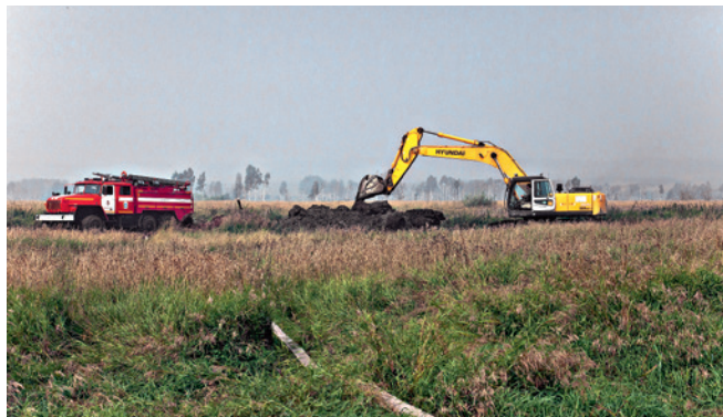
Рис. 59. Сооружение пирса и углубление места забора воды для АЦ. Иркутская область
